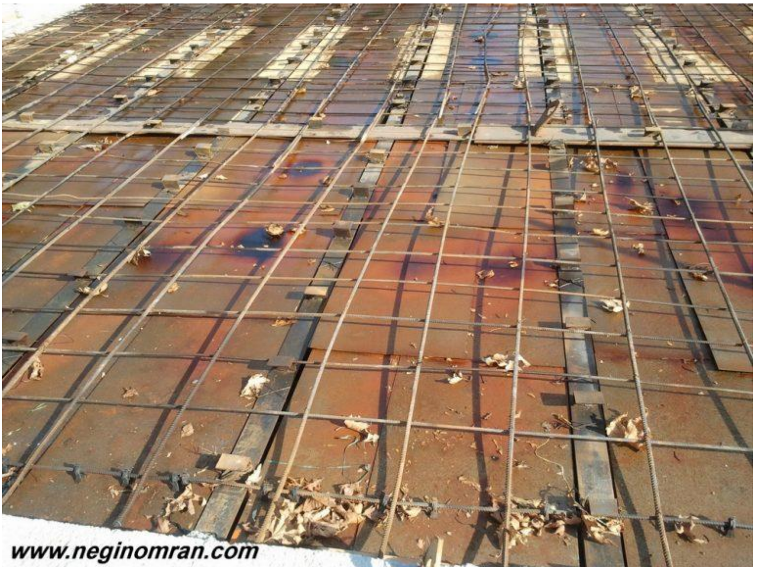
سقف کامپوزیت یا مرکب با پوشش دال بتنی
