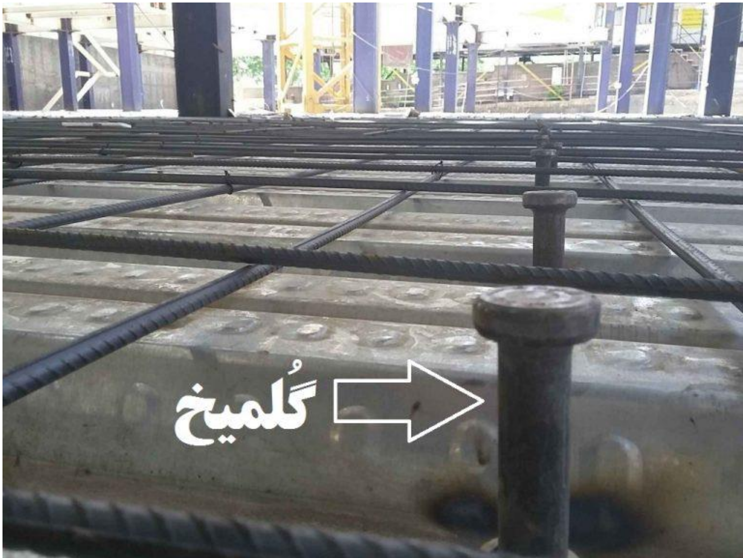
سقف مرکب با ورق های شکل دار شده و گلمیخ (عرشه فلزی)
